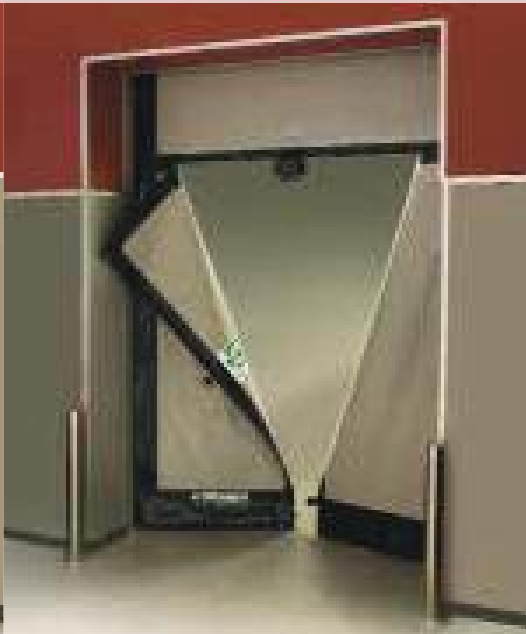
Otwarte wyjście ewakuacyjne
